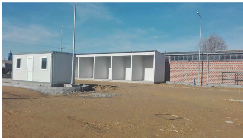
Фотографије новоизграђеног Рециклажног центра на локацији ЈКП "Чистоћа" Крагујевац у ул. Индустриска 12
